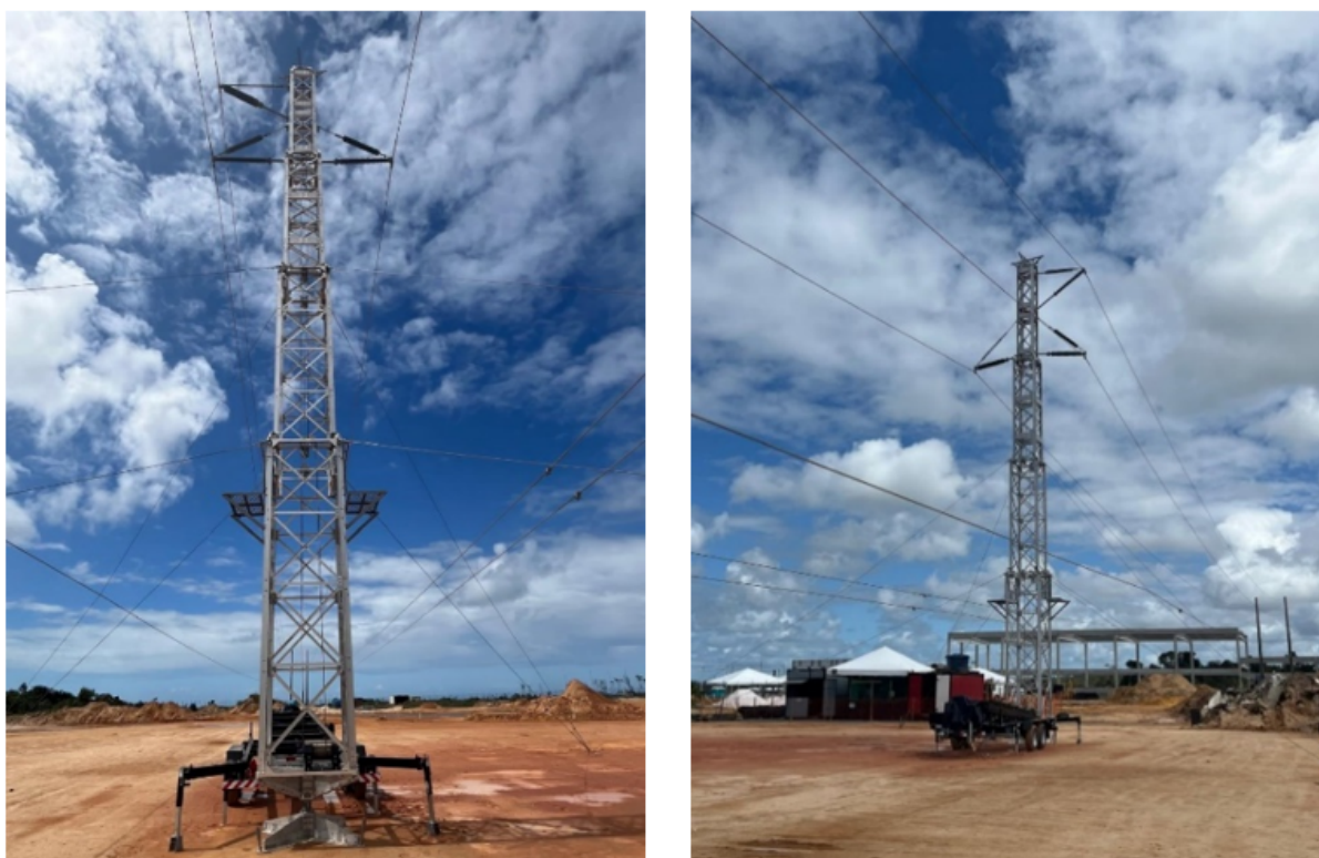
Figura 4 – Torre de Emergência instalada na configuração tipo Canadense.
