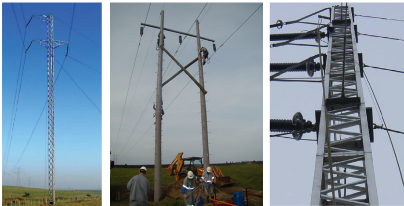
Figura 1 - Modelo da TET (à esquerda), exemplo de utilização da Torre de Fibra em coluna dupla (ao meio) e modelo 600L ERL montada (à direita).
