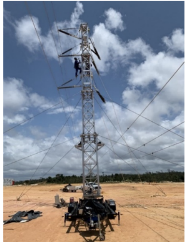
Figura 5 – À esquerda, Torre de Emergência na configuração de suspensão dupla e, à direita, na configuração com 3 fases paralelas.
