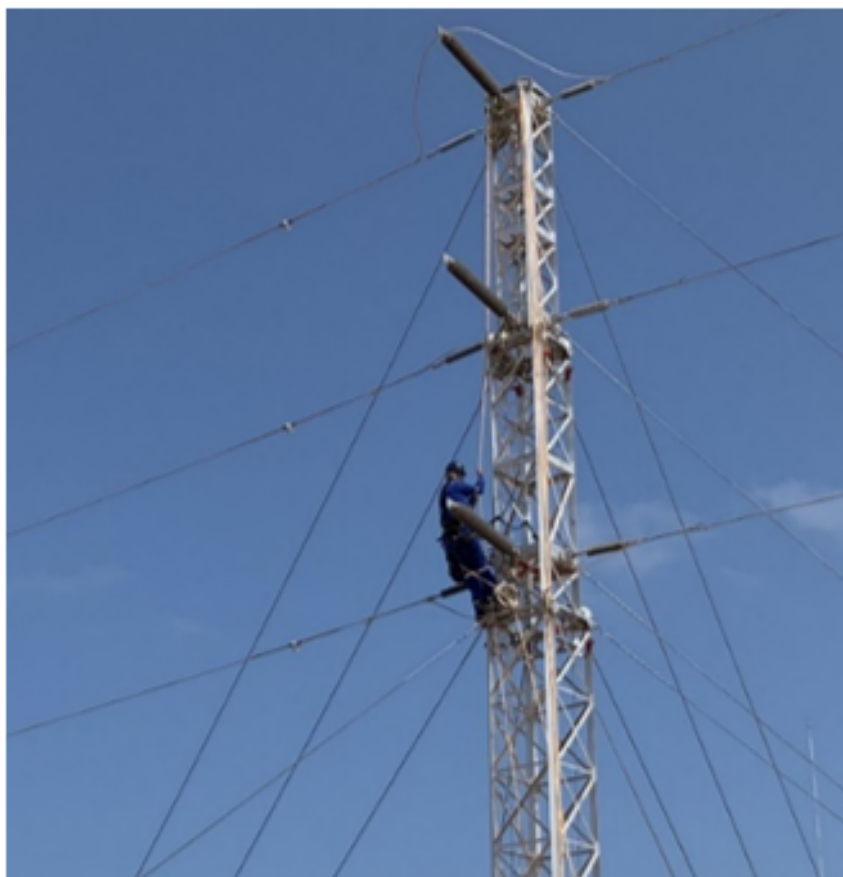
Figura 6 - Torre de Emergência na configuração ancoragem em ângulo.
